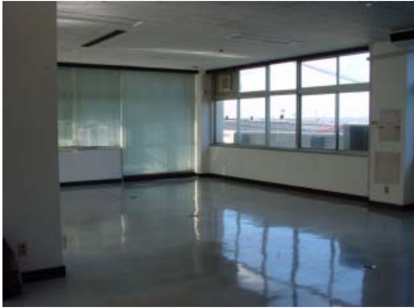
写真 2.1 事務所準備前の合同庁舎の様子
