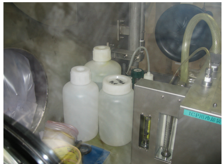
グローブボックスの中 重い装置は固定されている
