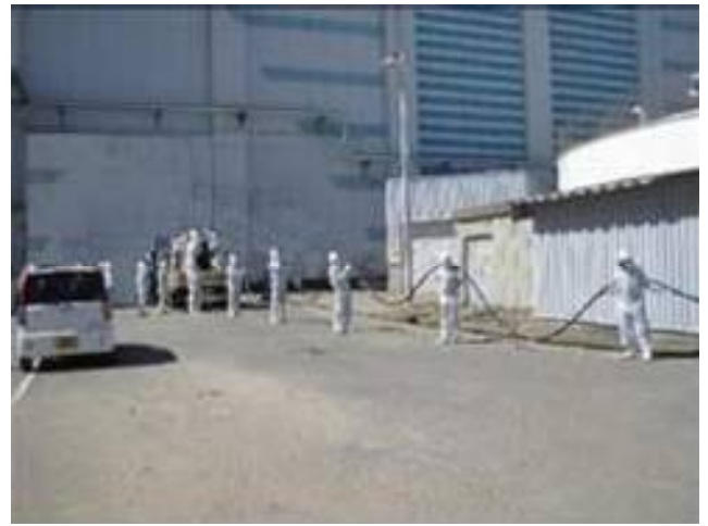
ケーブル敷設の様子（東京電力提供）
