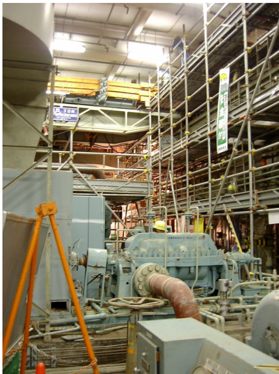
原子炉サービス建屋内の解体作業現場の様子
