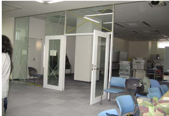
ガラスが割れ、災害対策室との仕切りがなくなった 合同協議会室(12月7日撮影)
