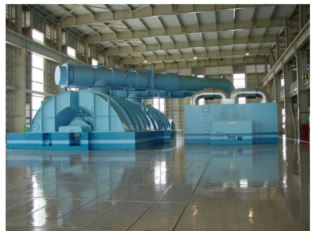
東京電力 常陸那珂火力発電所 タービン建屋内にて（5月25日） 100 万キロワットのタービン発電機は最高水準の効率を追求、環境対策も徹底
