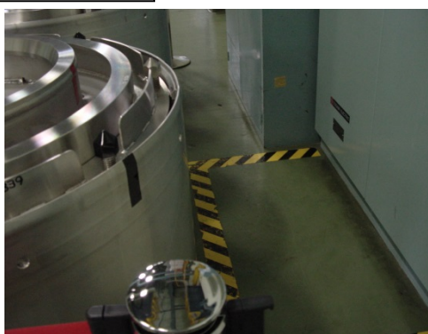
問題あり：一応スペースは開けてあるものの、手前のハル缶が邪魔でスイッチボックスに行きにくい（指摘後、缶はただちに撤去された）
