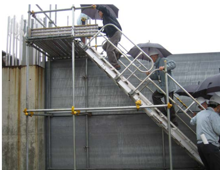
6.1mにかさあげされた壁(写真正面)が津波を防いだが、貫通部やピットから津波が浸入した。
