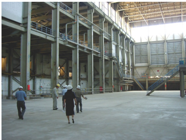
きれいに解体撤去されたタービン建屋内
