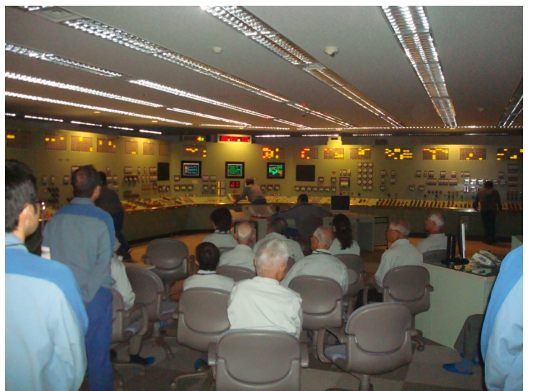
地震で外部電源を失い、非常用発電機に切り替わった状況
