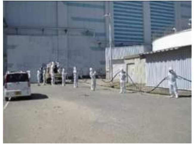
ケーブル敷設の様子（東京電力提供）
